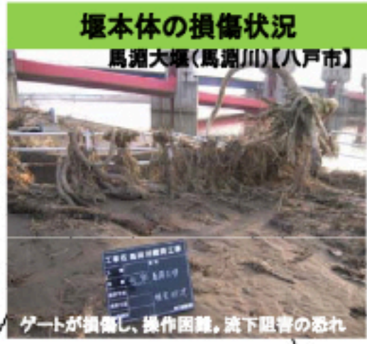
ゲートが損傷し、操作困難。流下阻害の恐れ
