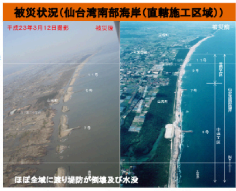
被災状況(仙台湾南部海岸(直轄施工区域))
