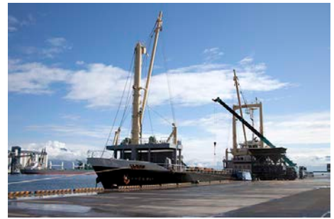
鹿児島港内貿バース
